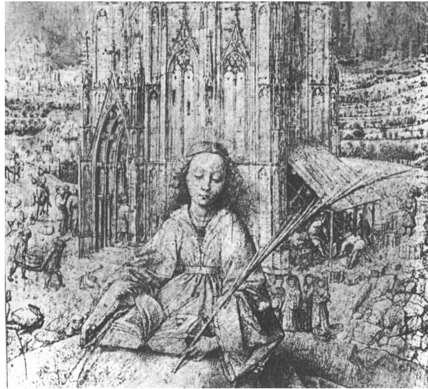
Figura 38 – “Santa Bárbara” de Van Eyck. Ao pé do edifício, uma loggia de talhadores de pedra. Extraído de GIMPEL, Jean. op.cit., 1973, p. 88.
